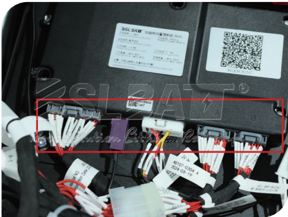
2 Retire el arnés de conexión en la parte superior del BMS Remove the wiring harness above the BMS
